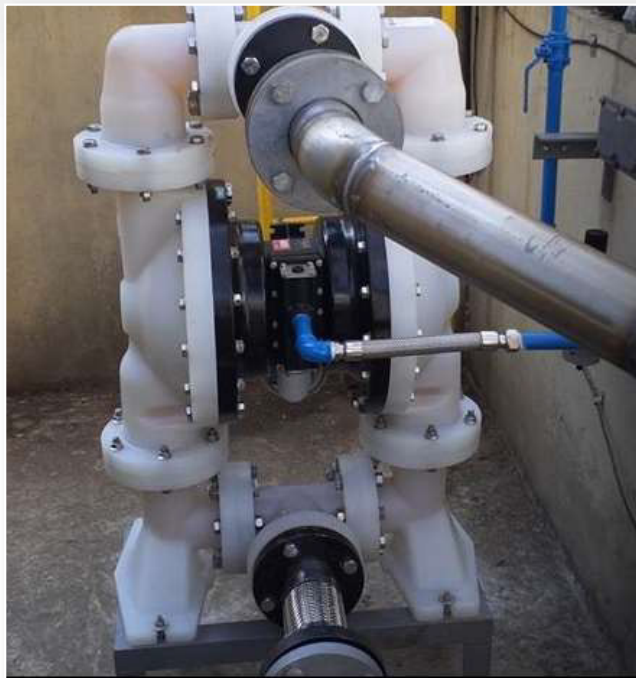
ARO EXP 系列 3" 非金属泵，适合化学品高效输送。
